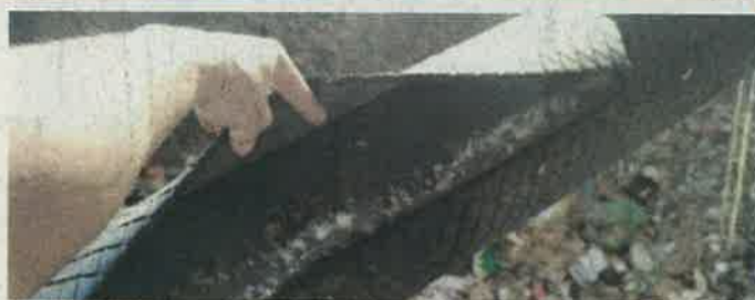
Poškodovan pogonski valj transportnega traku. Velik kos armiranega betona je povzročil poškodbo – lom konstrukcije traku – poškodbo transportne gume in pogonskega valja.
